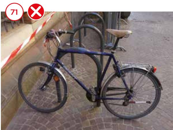
Il est important d'apporter un soin particulier au positionnement des arceaux lors de leur installation. S'ils sont placés trop près d'un mur, il n'est pas possible d'appuyer les vélos correctement. → **Photo 71**
