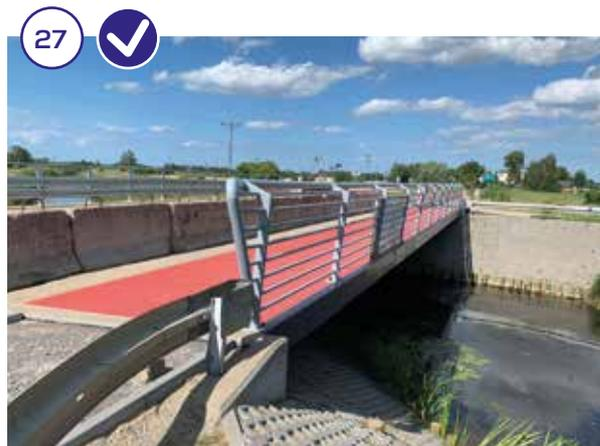
Plancher antidérapant, le revêtement est celui des pistes des porte-avions, ininflammable, pouvant être antigel, pour cela un cordon chauffant est mis en place dans les alvéoles. ➔ **Photos 26 - 27**
