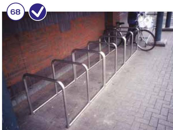
→ Photo 66 Les parkings à arceaux, de type "U" inversé ont la faveur des cyclistes. Le vélo est bien soutenu, et il est possible d'attacher le cadre, voire même les deux roues.
