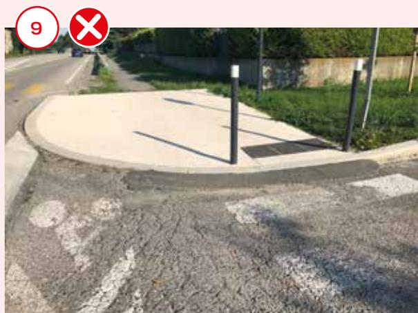
→ **Photo 7** Réfection totale d'une chaussée en agglomération en 2019 intégrant un ralentisseur type chicane sans création d'aménagement cyclable ! Il y a suffisamment d'espace pour transformer le bas-côté et le trottoir en bande cyclable.
