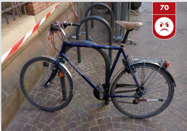
Il est important d'apporter un soin particulier au positionnement des arceaux lors de leur installation. S'ils sont placés trop près d'un mur, il n'est pas possible d'appuyer les vélos correctement. → **Photo 70**
