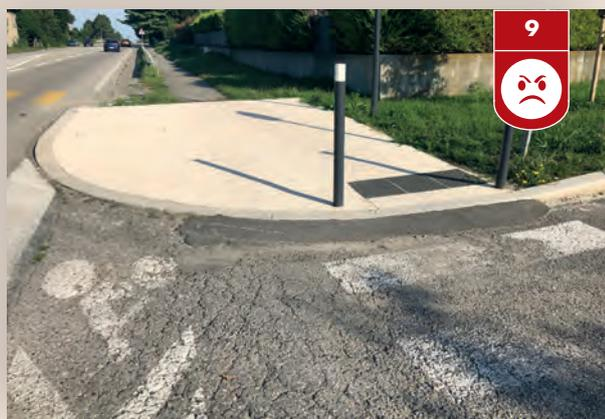
➔ **Photo 7** Réfection totale d'une chaussée en agglomération en 2019 intégrant un ralentisseur type chicane sans création d'aménagement cyclable ! Il y a suffisamment d'espace pour transformer le bas-côté et le trottoir en bande cyclable.
