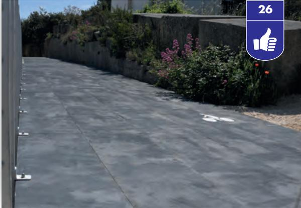
Plancher antidérapant, le revêtement est celui des pistes des porte-avions, ininflammable, pouvant être antigel, pour cela un cordon chauffant est mis en place dans les alvéoles. ➔ **Photos 26 - 27**
