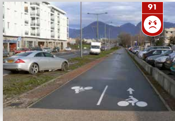
Un exemple de cohabitation à ne pas suivre : aucun passage pour les piétons et personnes à mobilité réduite.
