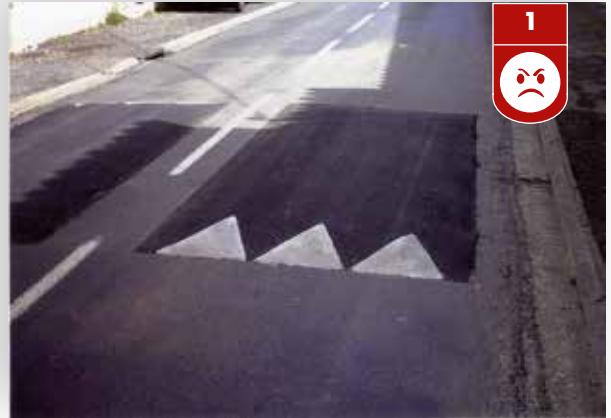
" Zone 30 " avec réducteur de vitesse mais ralentisseur posé trop près du trottoir.
