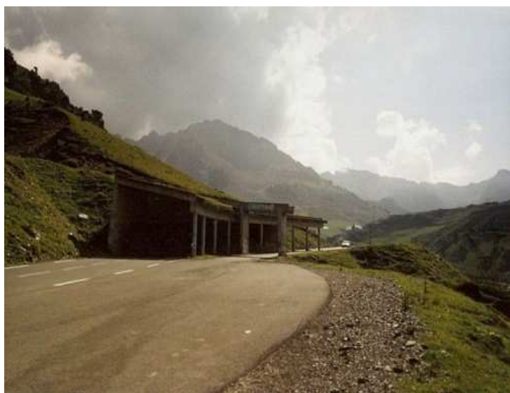
Les pare-avalanches avant la Mongie.
