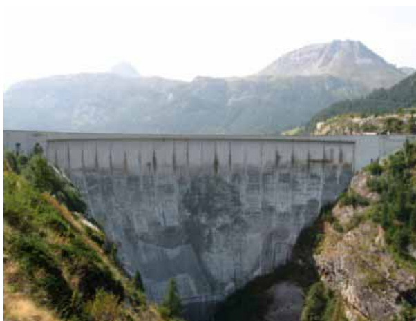
Le géant du barrage de Tignes.
