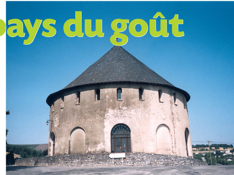
La tour, ancienne aire de battage et sa belle charpente ▲
