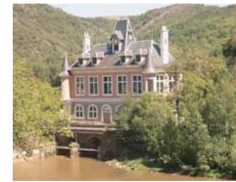
▲ La demeure de la fée électricité.
