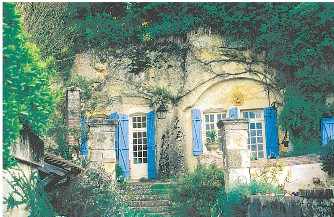
Creusée dans le roc, la maison troglodyte se cache derrière les feuillages © Jacques Blondel
