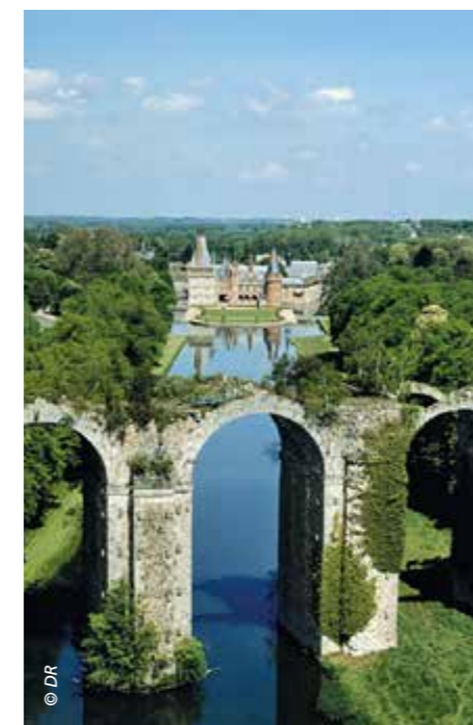
L'aqueduc et le château.
