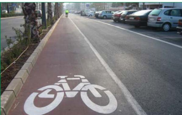
▲ Séparation des cheminements cyclables et positionnement décalé par rapport au stationnement des véhicules à moteur. **Sécurité maximum pour les cyclistes.**
