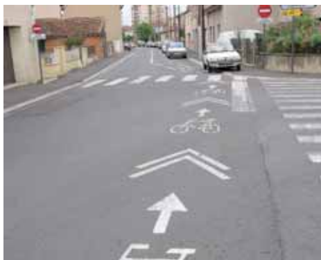
▲ Marquage renforcé en intersection.
