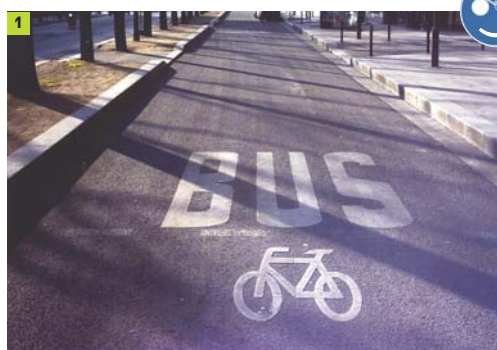
photo 1 Exemple de couloir dit fermé, par un séparateur non franchissable
