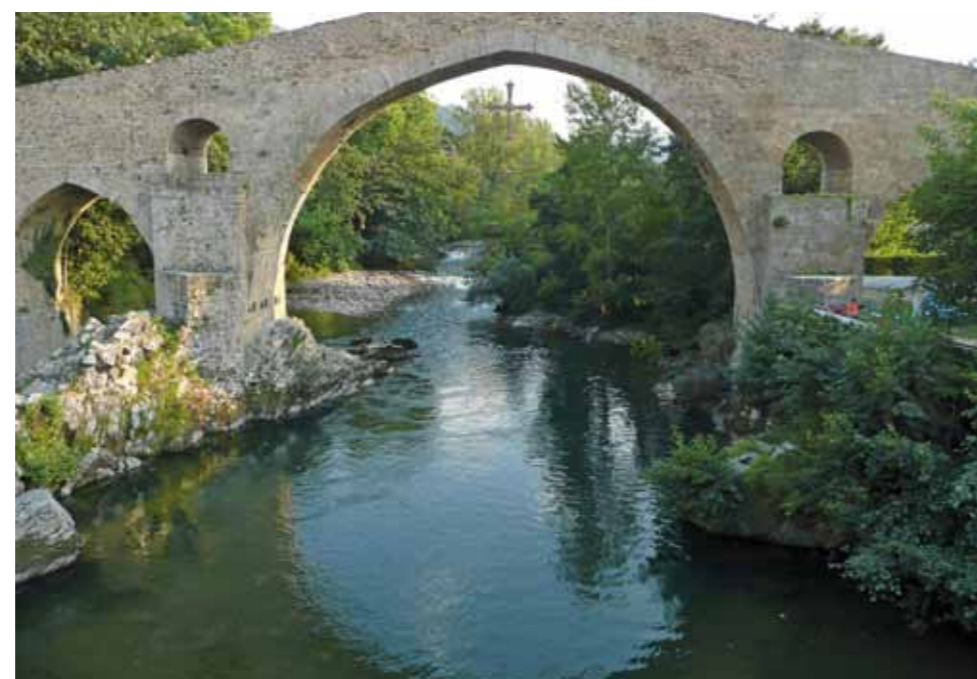
Le pont de Cangas de Onís
