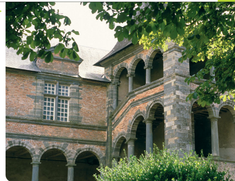
▶ Arcade à l'italienne du pavillon renaissance
