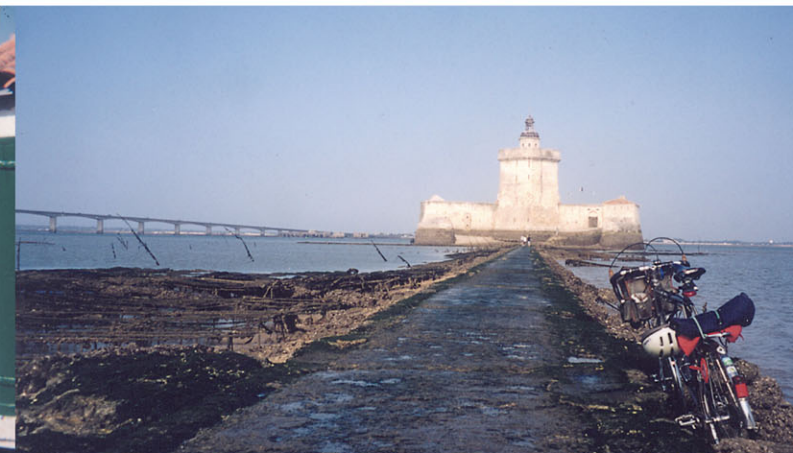
▶ Il suffit de passer le pont... Fort Louvois.
