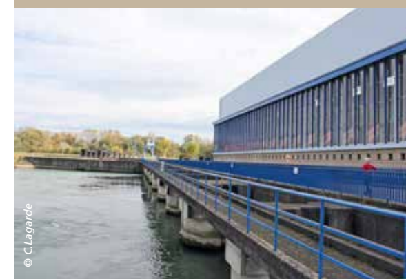
L'usine hydroélectrique de Rhinau.
