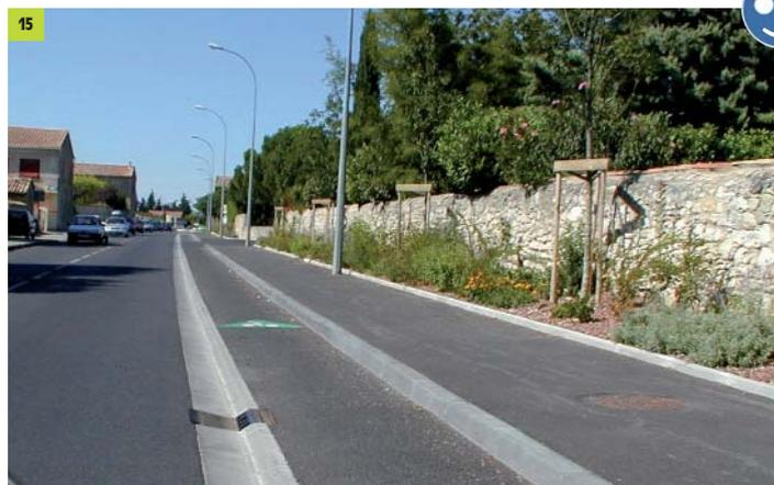
Cette solution peut être utilisée dans tous les secteurs, urbains et interurbains, la largeur recommandée de la piste cyclable bidirectionnelle est de 1,70 m minimum pour permettre aux cyclistes de se doubler sans difficulté majeure (ce n'est pas le cas sur l'exemple de la photo 15 qui représente une piste unidirectionnelle).
