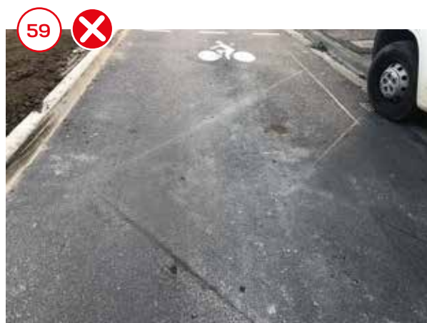
Création en septembre 2021 d'un carrefour à feu sans sas avec un système de capteurs au sol détectant le métal... quid des vélos tout carbone ?
